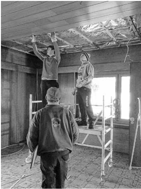
Abriss der Decke im VfB-Nebenzimmer
